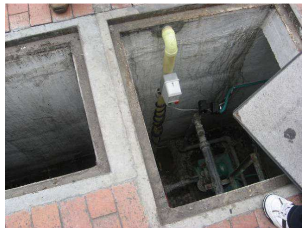
EXISTENCIA DE BARANDAS MAL EMPOTRADAS Y FALLAS EN EL EQUIPO HIDRONEUMATICO INSTALADO CON PRESUNTOS PROBLEMAS EN EL IMPERMEABILIZADO DEL TANQUE
