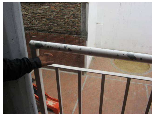
EXISTENCIA DE BARANDAS MAL EMPOTRADAS Y FALLAS EN EL EQUIPO HIDRONEUMATICO INSTALADO CON PRESUNTOS PROBLEMAS EN EL IMPERMEABILIZADO DEL TANQUE
