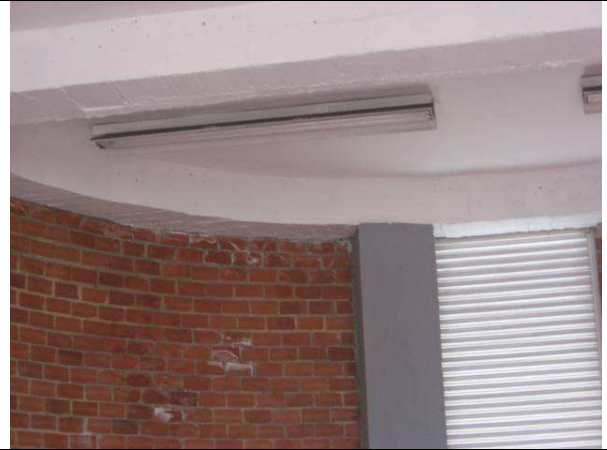
PRESENCIA DE HUMEDADES EN MUROS
