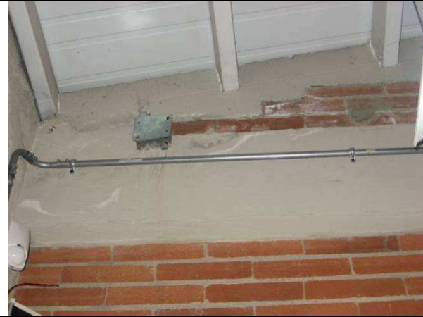
PRESENCIA DE HUMEDADES EN MUROS
